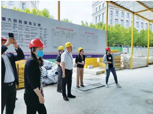
▲ 实地走访江湾校区新建宿舍园区工地
